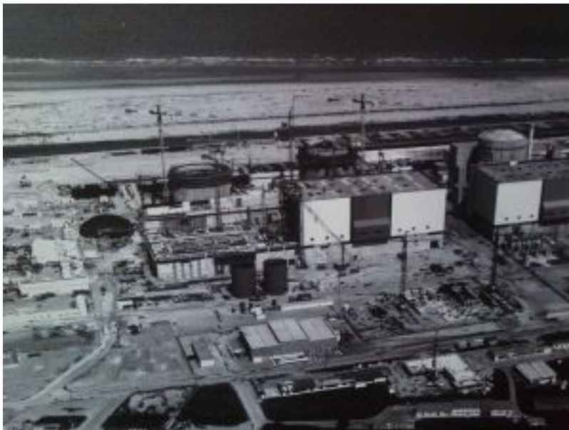
Construction des tranches 5 et 6 de la centrale nucléaire de Gravelines.
